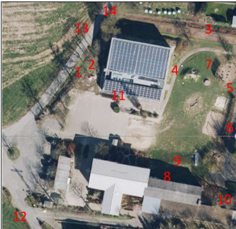
Luftbild des Schulgeländes (Quelle: TIM-online NRW)
