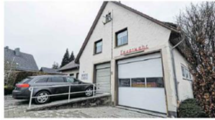
Im Dachgeschoss des Feuerwehrgerätehauses in Bentorf könnte ein Jugendraum entstehen. Foto: Gemeinde Kalletal
