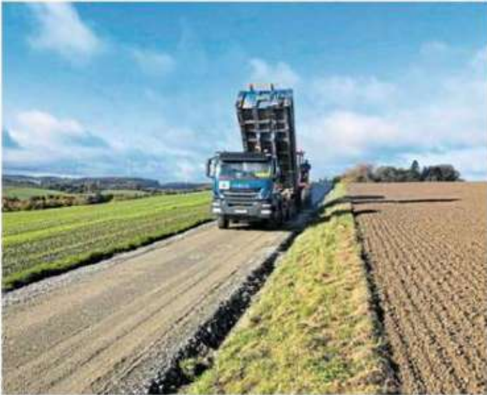
In Kalletal werden Wirtschaftswege saniert.
