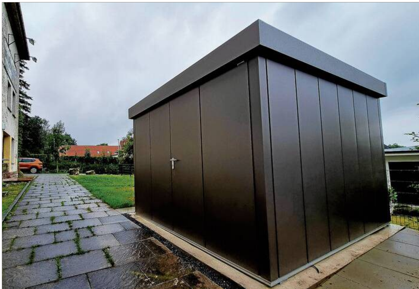
Das neue Spiel- und Gerätehaus befindet sich direkt am Kalletaler Jugendzentrum in Hohenhausen. Das Regionalbudget-Projekt aus dem vergangenen Jahr ist damit jetzt abgeschlossen. Foto: pr.
