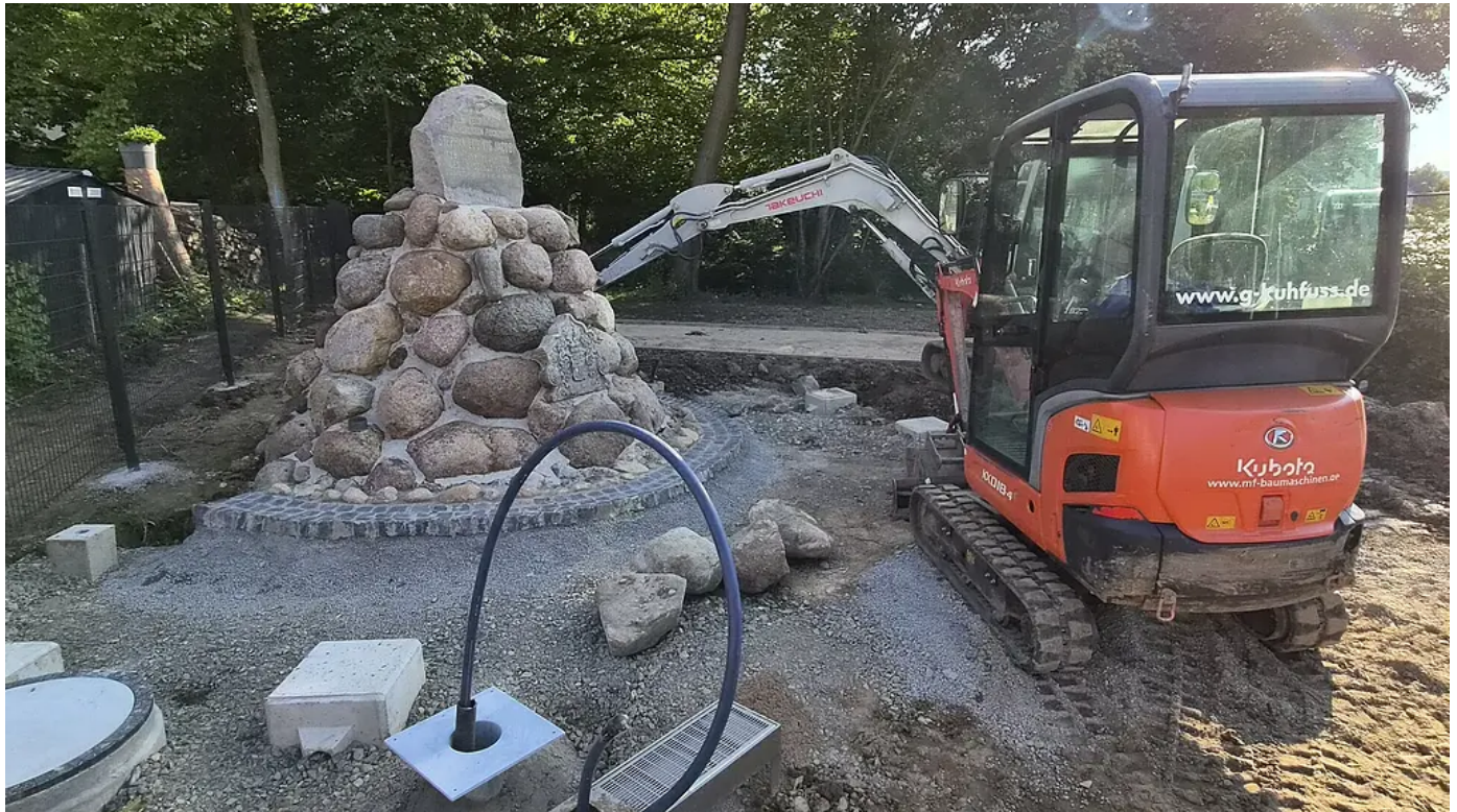
Ein Blick auf die aktuelle Baustelle. Die Basaltpflasterrinne, die bereits halbrund vor dem Denkmal angelegt wurde, dient als kleiner Bachlauf und stellt einen Bezug zu Jacobis Wirken im Bereich der Fischzucht her. Foto: Gemeinde Kalletal
