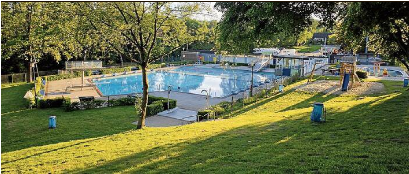
Idyllisch gelegen und bald noch attraktiver: Das Freibad Kalletal soll künftig mit einem Wasserspeier/Wasserfall als zusätzlichem Erlebnisangebot punkten. Foto: pr.
